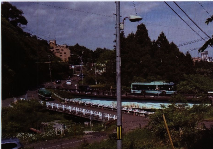
手前 旧聖沢橋、奥 現在の聖沢橋
